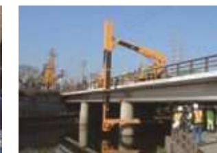
橋梁点検の実習
