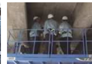
目視点検実習
