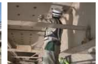
床版下面の目視点検
