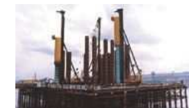
鋼管矢板基礎打設状況 (阪神高速大和川橋梁)
