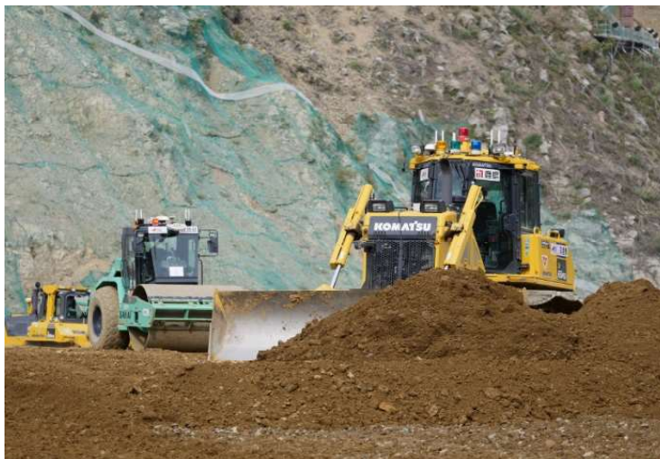
小石原川ダムでのA 4 CSELによる盛立作業
