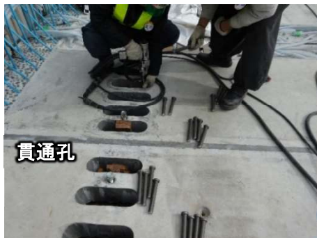
ずれ止めスタッドの設置(玉出入口)
