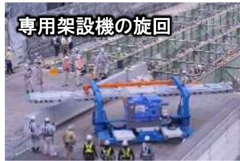
専用架設機の旋回 所定位置へ運搬するために UFC 道路橋床版を把持したまま旋回
