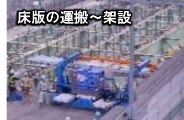
床版の運搬～架設 所定の位置まで運搬したのち、UFC 道路橋床版を降下して架設
