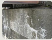
近接目視・ 写真撮影
