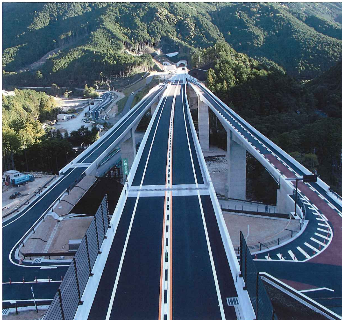
国道42号線賀田三木里(三重県)
