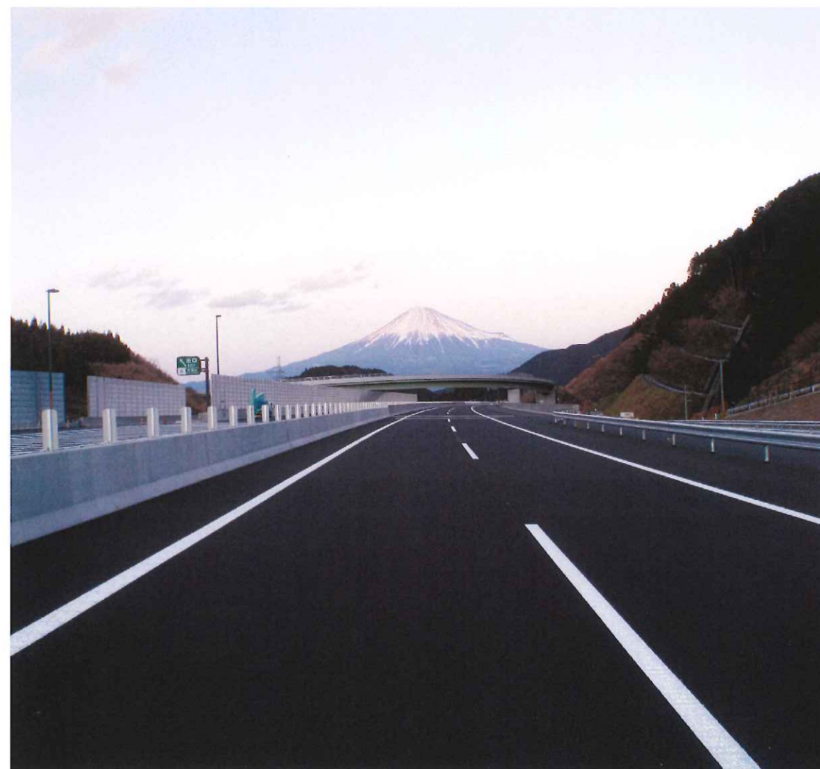
新東名高速自動車道 清水東(静岡県)
