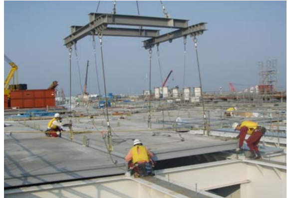
UFC床版の架設（羽田D滑走路外周部）
