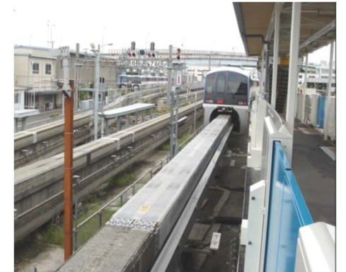
昭和島に適用されたUFC軌道桁
