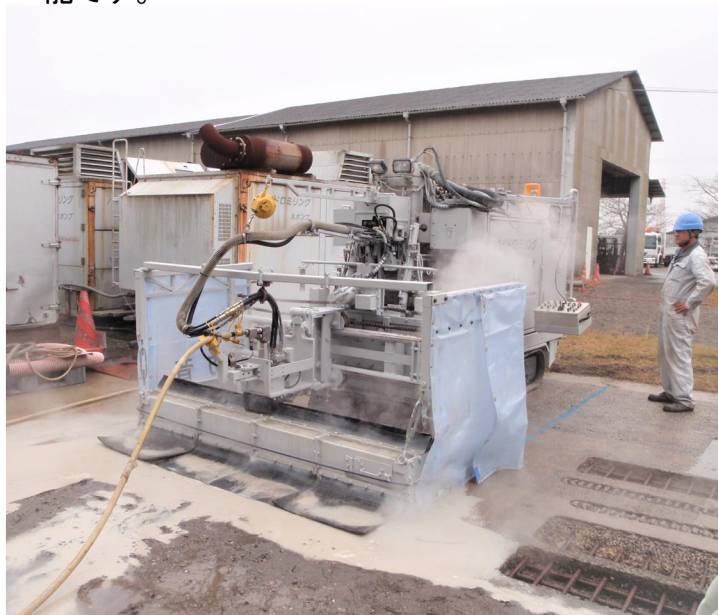
コンクリート除去状況
