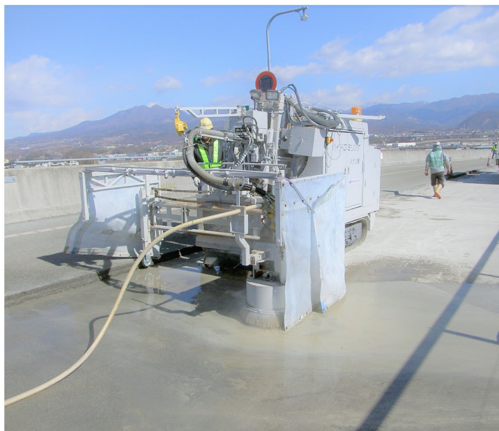
研掃処理施工状況
