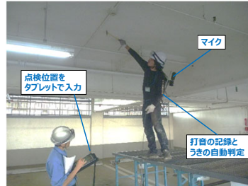
建物の劣化点検
