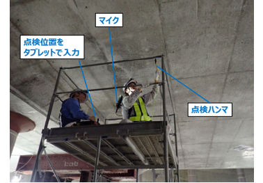
地下RC構造物点検
